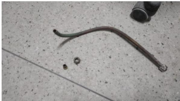
Retirado tubulação de cobre para reparo de solda
