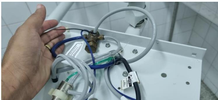
**Equipo, retirado vazamento, feita limpeza revisado Ok**
