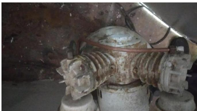
**Compressor feito reparo e substituição do componente da tubulação de cobre**
